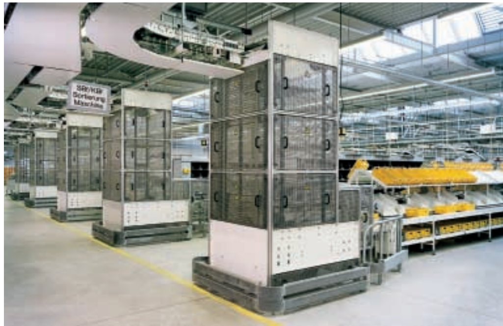
Hohe Mengenleistungen auf engstem Raum im Briefverteilsystem der Post
