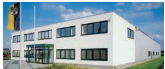
Außenansicht des Werkes in Salzwedel zur Herstellung der NERAK Gummiblockketten
